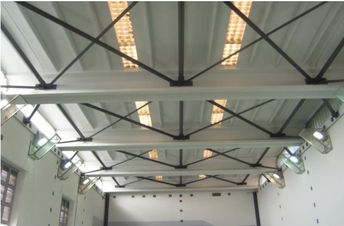
Sistema reticolare Controventatura di piano
