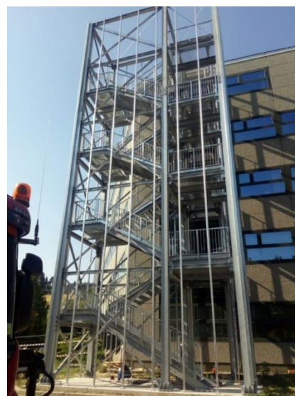
Scala di emergenza in acciaio S275JR completa di gradini in lamiera stampata e balaustra, tutto zincato a caldo.
