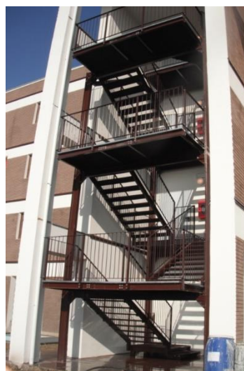
Scala di emergenza in acciaio S275JR completa di gradini in lamiera stampata e balaustra, tutto zincato a caldo.
