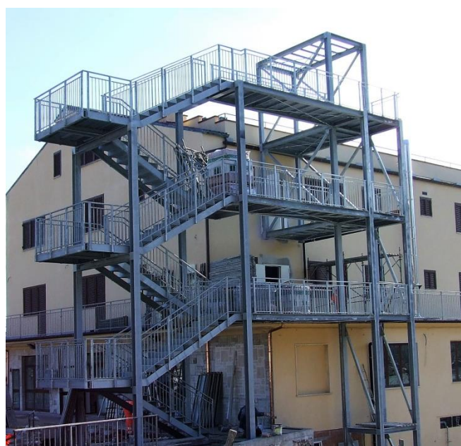
Scala di emergenza in acciaio S275JR completa di gradini in lamiera stampata e balaustra, tutto zincato a caldo.
