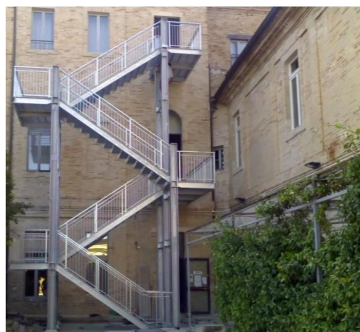
Scala di emergenza in acciaio S275JR completa di gradini in lamiera stampata e balaustra, tutto zincato a caldo.
